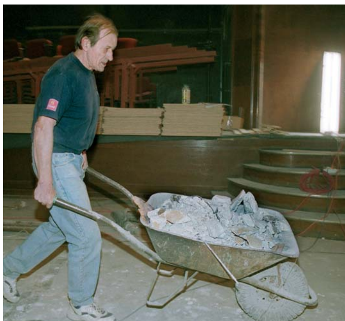
Radek Brzobohatý také přiložil ruku k dílu při dokončování rekonstrukce divadla.
